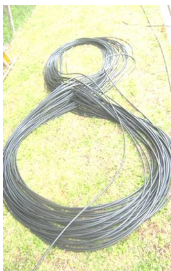
Figura 4 Reserva de cabo, figura oito
